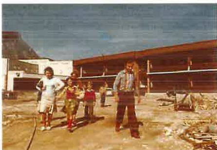
Gradnja šole na Plavžu
